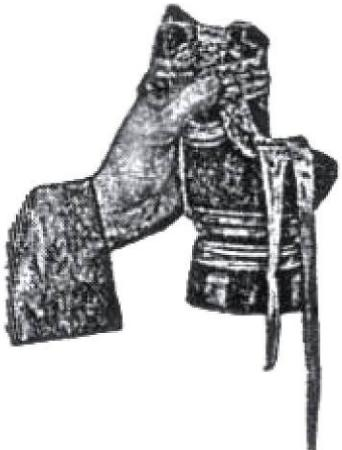
**Fünf! Bild e.** Die rechte Hand legt das Stirnband von oben über den Maskenrand hinweg und die Kopfbänder seitlich um die Maske auf das linke Augenglas, wo sie mit dem linken Daumen festgehalten werden.
